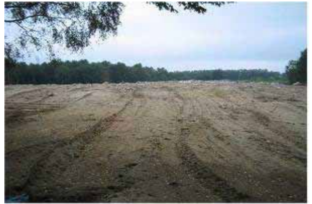
Լուսանկար 8. Կրուզլովո աղբանոցի ձևավորված և ծածկված հատվածը (տեսքը հյուսիսից): Թափոնների բեռնաթափումը և տեղադրումը այլևս իրականացվում է հետին պլանին երևացող աշխատանքային գոտում
