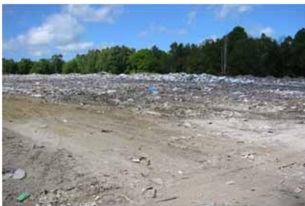
Լուսանկար 5. Թափոնների ծածկմանը նախորդող խտացման, մակերեսի ձևավորման և գմբեթաձև բարձրացման գործընթացը
