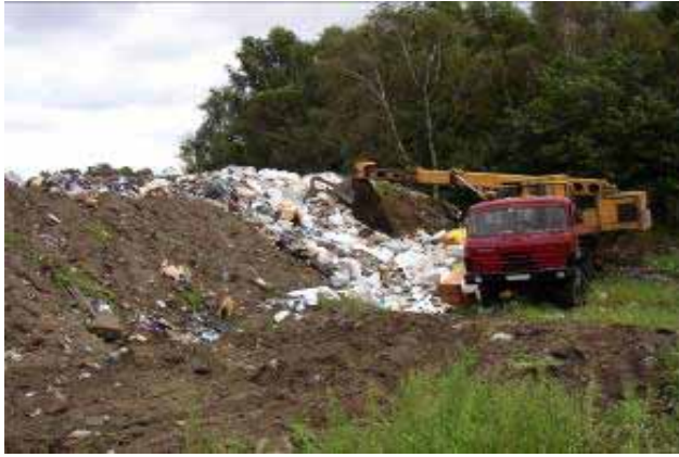
Լուսանկար 13. Մեկուսիչ լիրաթմբի կառուցումը և ամրապնդումը աղբանոցի հարավ-արևմտյան հատվածում
