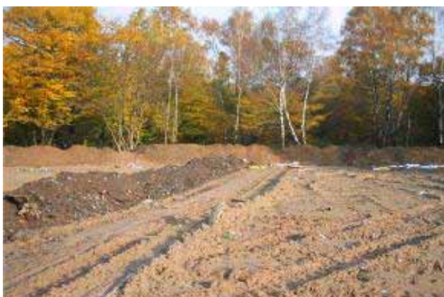
Լուսանկար 15. Արտաքին մեկուսիչ լիրաթմբի և թափոնների տեղադրման հատվածի ներքին (կենտրոնական) մեկուսիչ լիրաթումբը
