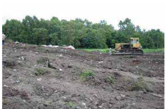
Լուսանկար 6. Աղբանոցի արևմտյան սահմանի մոտ մեկուսացնող լիրաթմբի (պատի) կառուցման գործընթացը, որի նպատակն է կանոնավորել և պատշաճորեն ձևավորել աղբանոցի մակերեսը
