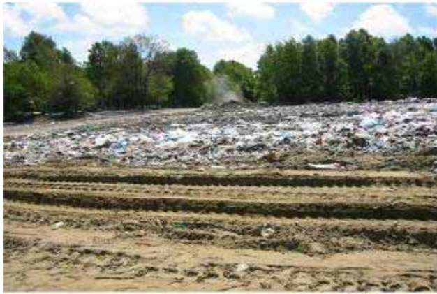
Լուսանկար 7. Աղբանոցի տարածքի խտացված և դասավորված մասի «քայլ առ քայլ» ծածկումը
